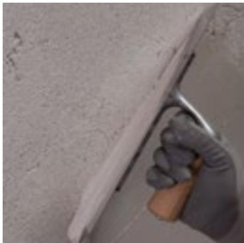
Malta da rasatura traspirante a tessitura fine, resistente ai sali, a base di calce ed Eco-Pozzolana, per la finitura civile di intonaci.
