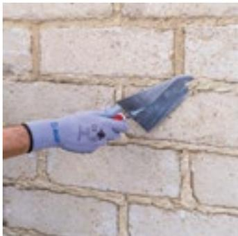
Malta da muratura resistente ai sali, a base di calce idraulica naturale ed Eco-Pozzolana, per la stilatura e l'allettamento di murature "faccia a vista"
