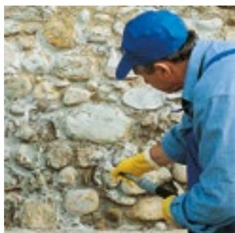
Legante idraulico fillerizzato superfluido, resistente ai sali, a base di calce ed Eco-Pozzolana, per confezionare boiacche da iniezione per il consolidamento di murature
