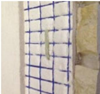
Malta per intonaci traspiranti e da muratura, ad elevate prestazioni meccaniche, a base di calce idraulica naturale ed Eco-Pozzolana, particolarmente indicata per realizzare intonaci “armati” ed allettamenti
