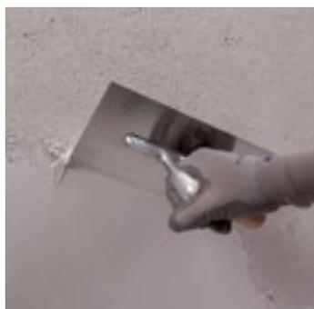
Malta da rasatura traspirante a tessitura ultrafine, resistente ai sali, a base di calce ed Eco-Pozzolana, per la finitura liscia di intonaci
