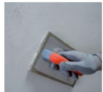
Rifinitura della superficie con frattazzino di spugna
