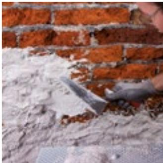
Malta da rinzafo traspirante, resistente ai sali, a base di calce ed Eco-Pozzolana, da applicare come primo strato nella realizzazione di intonaci deumidificanti, traspiranti e “strutturali”
