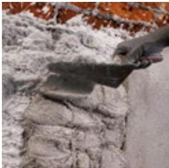
Malta per intonaci deumidificanti macroporosi resistente ai sali, a base di calce ed Eco-Pozzolana, per il risanamento di murature esistenti, anche di pregio storico
