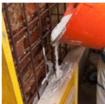
Malta da muratura colabile, resistente ai sali, a base di calce idraulica naturale ed Eco-Pozzolana, per la rigenerazione ed il consolidamento di murature
