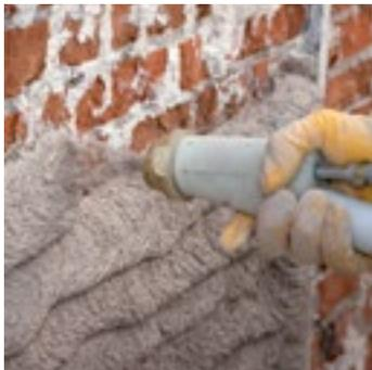
Intonaco di fondo traspirante a base di calce idraulica naturale ed Eco-Pozzolana, da applicare su murature esistenti, anche di pregio storico, o di nuova costruzione
