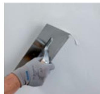
Applicazione di un secondo strato di rasatura a tessitura ultrafine
