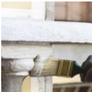
Rivestimento elastico bicomponente resistente ai sali, a base di calce ed Eco-Pozzolana, esente cemento, per l'impermeabilizzazione e la protezione di elementi costruttivi, anche di pregio storico e artistico.
