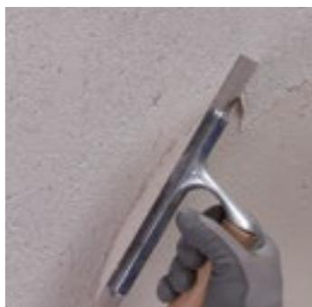
Malta da rasatura traspirante a tessitura grossa, resistente ai sali, a base di calce ed Eco-Pozzolana, per la finitura grossa di intonaci.
