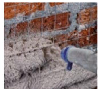
Applicazione a macchina dell'intonaco “strutturale”
