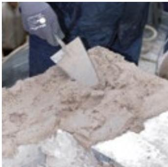
Malta per intonaci traspiranti e da muratura, ad elevate prestazioni meccaniche, a base di calce idraulica naturale ed Eco-Pozzolana, particolarmente indicata per realizzare intonaci “armati” ed allettamenti
