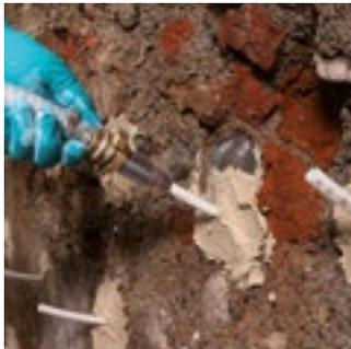
Legante idraulico fillerizzato, resistente ai sali, a base di calce ed Eco-Pozzolana, per confezionare boiacche da iniezione superfluide per il consolidamento di murature
