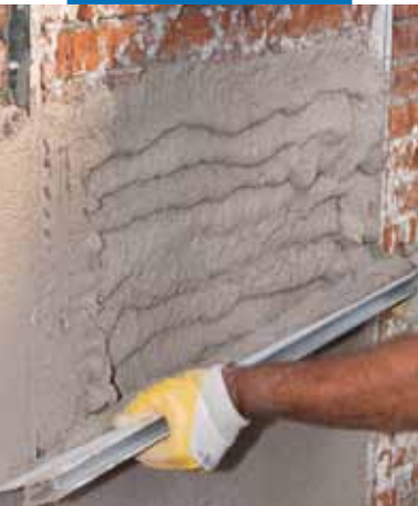
Staggatura di Mape-Antique Intonaco NHL
