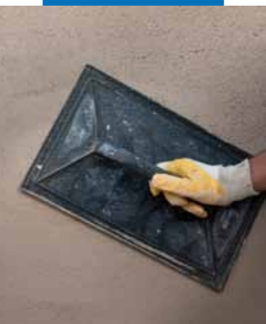
Ripianatura di Mape-Antique Intonaco NHL
